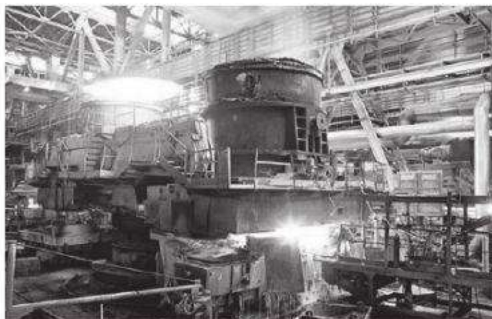
Hình 24.4. Một góc nhà máy luyện kim
